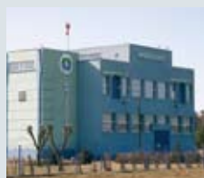
Miejskie Wodociągi i Oczyszczalnia, Grudziądz, Polska
