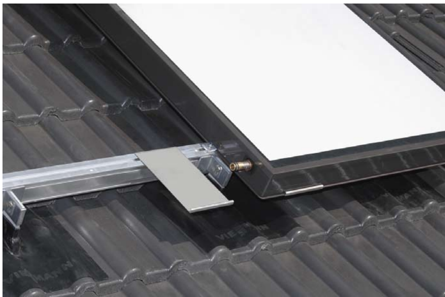
Montaż kolektorów słonecznych na dachu zajmuje wykwalifikowanym specjalistom zazwyczaj 1 dzień
